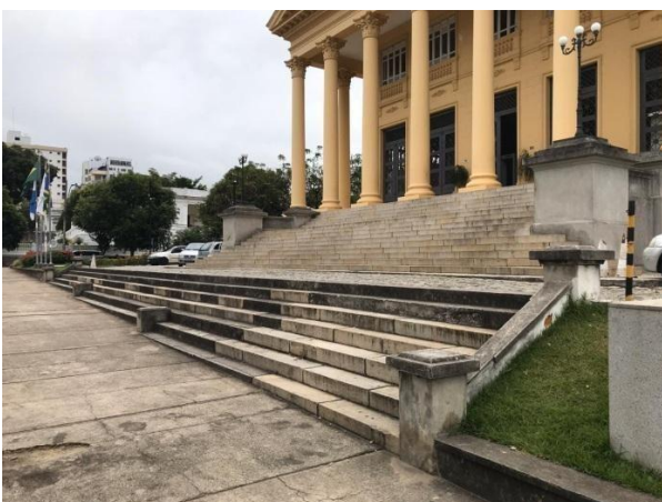
Imagem 10 – Escadaria de acesso à Câmara Municipal.
