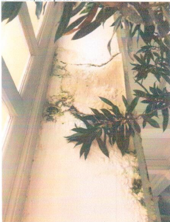
25 - Infiltração em parede interna
