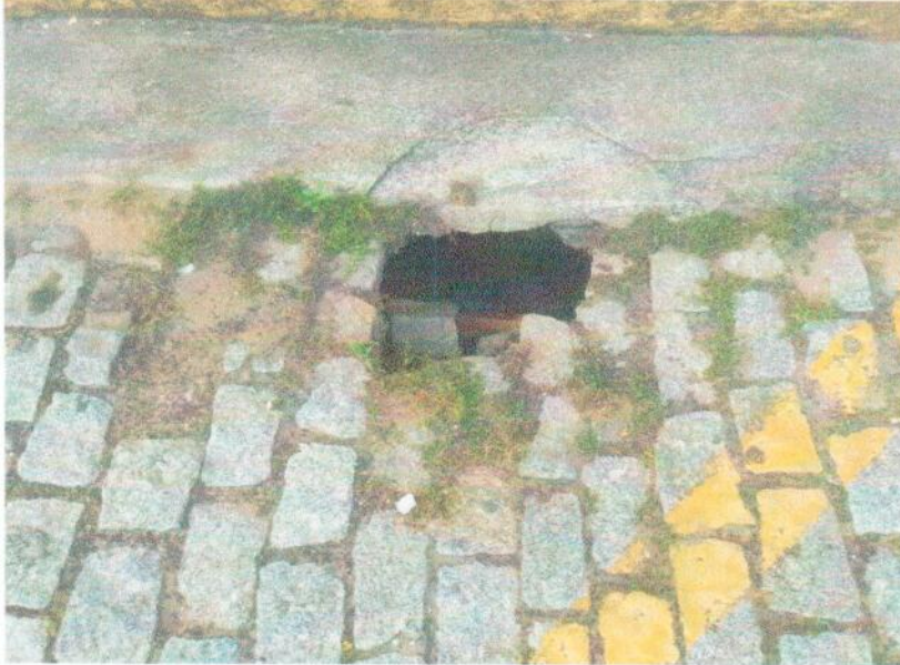
17 - Pavimentação em paralelo do estacionamento com afundamentos
