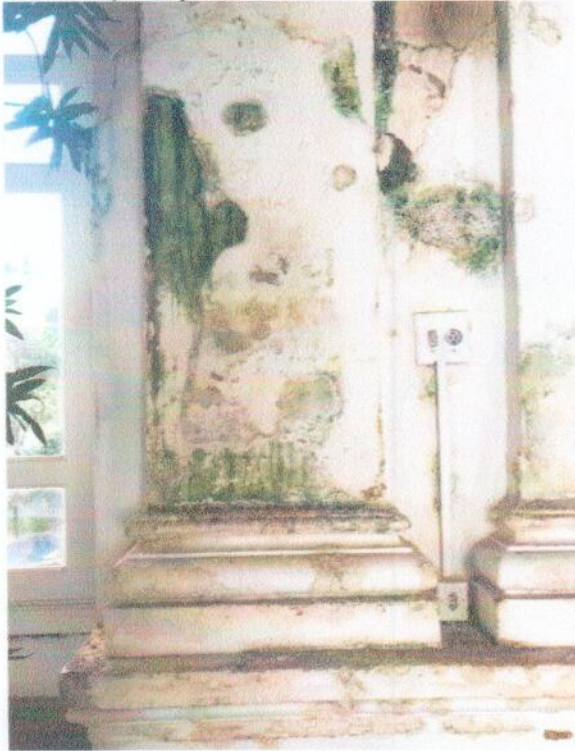
27 - Infiltração em parede interna
