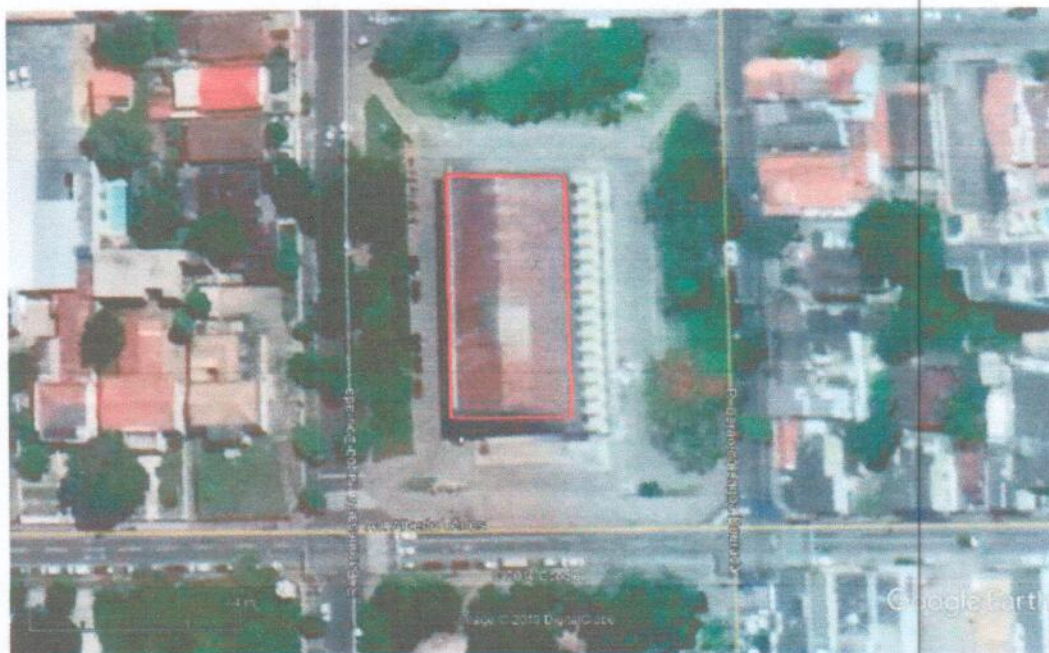
Foto 01: Vista de Satélite da Sede da Câmara Municipal.
