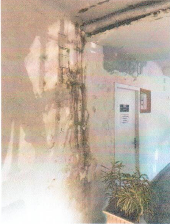
29 - Infiltração em parede interna
