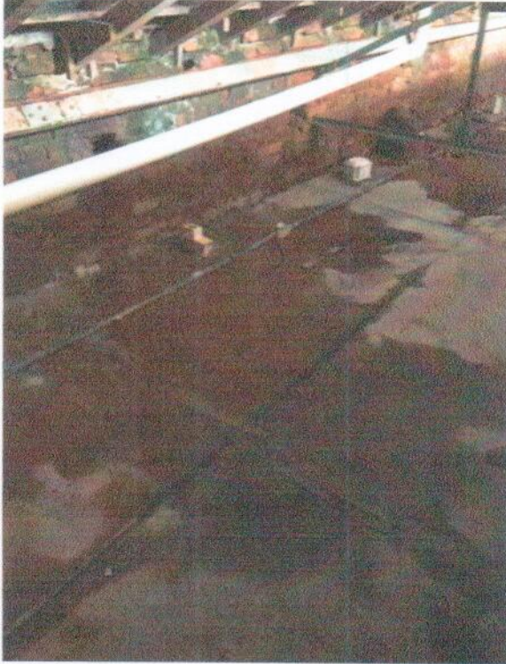
22 - Infiltração sob o telhado
